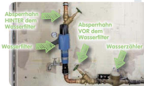
5. Zum Abschluss zuerst den Absperrhahn VOR DEM FILTER öffnen, dann den zweiten. Vergewissern Sie sich zuletzt noch einmal, ob alle Verbindungen dicht sind.
